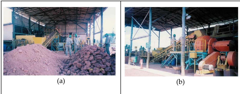
Figura 3 – Detalhes da instalação da unidade piloto de moagem autógena existente no CETEM. Em (a) pilhas de amostras para alimentação do moinho e, em (b), circuito de moagem.
