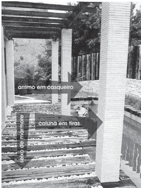
Foto 18 – Arrimo com blocos de casqueiro, colunas em tiras e seixo rolado feito de sobras de mármore. Obra R. Azevedo. Capa e matéria da Revista Pedras do Brasil. 2002 (foto do César Romero).
