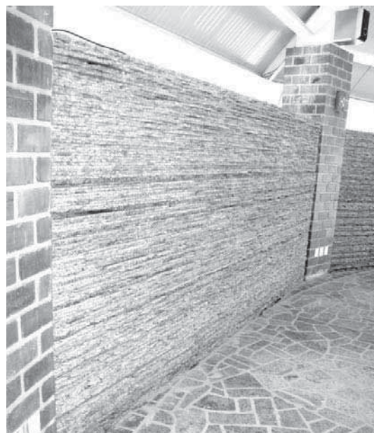
Foto 13 – Pannelo interno. Obra Jaciguá. 2006 (foto do autor).
