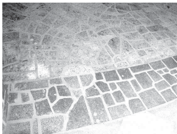
Foto 24 – Piso em cacos. Obra Jaciguá. 2006 (foto do autor).
