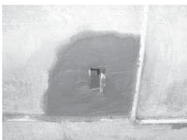
**Figura 14** – Argamassa com lama Abrasiva
