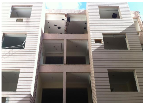
Figura 3: Demolição Seletiva
