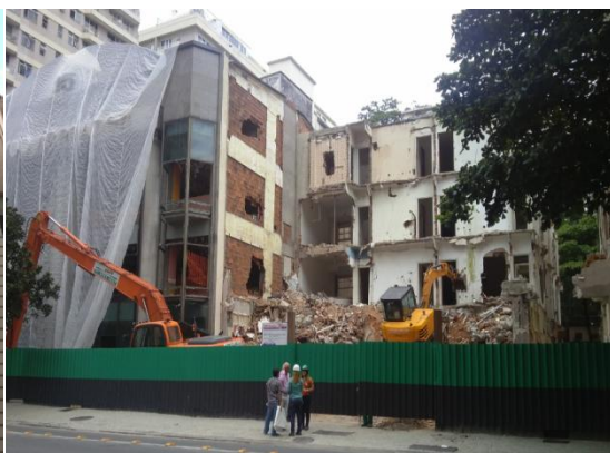
Figura 4: Demolição Destrutiva
