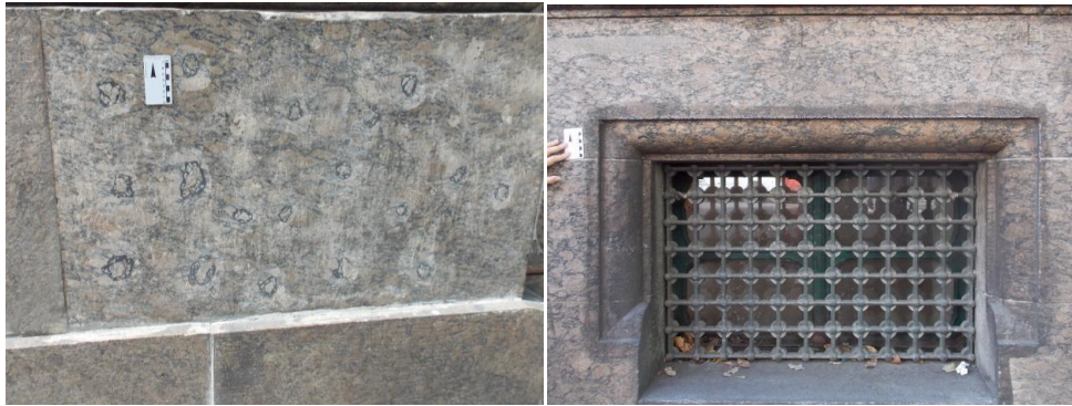
Figura 5: Intervenção inadequada no preenchimento de porfiroblastos no CCBB e crosta negra e excesso de produto no CCJE.
