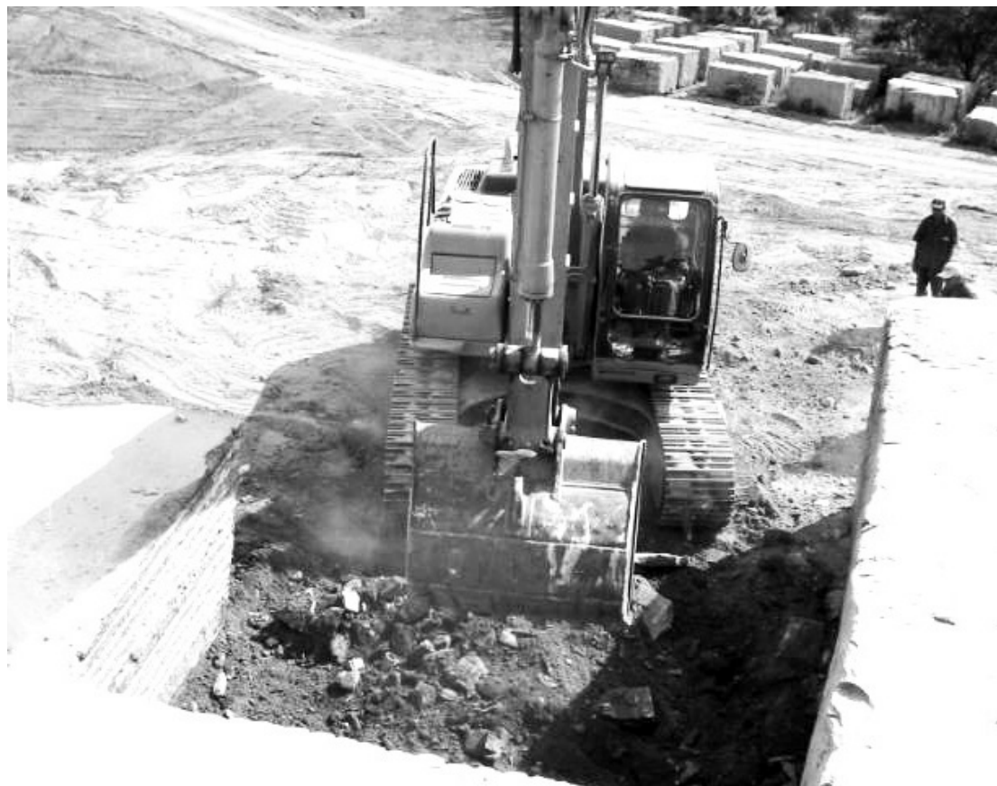
Figura 15 - Escavadeira utilizada na Pesquisa Tecnológica Industrial. Foto: CBPM, 2002.
