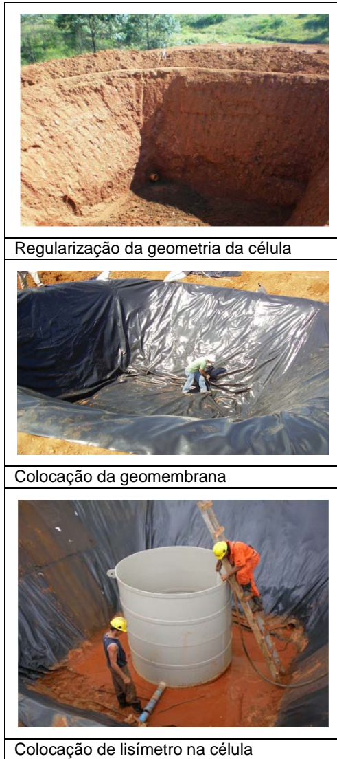
Figura 4. Colocação de geomembrana e lisímetro na célula.
