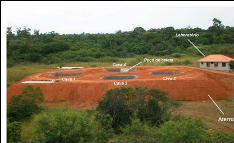
Área com aterro
