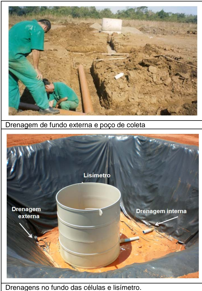
Figura 3. Drenagens das células e lisímetro.
