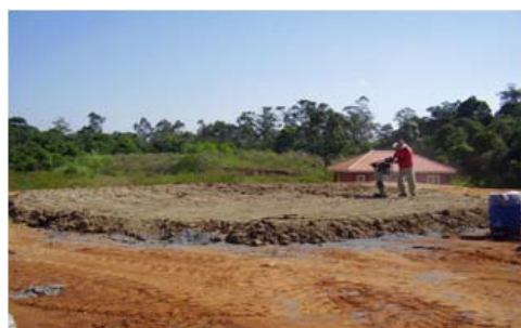
Compactação da argila
