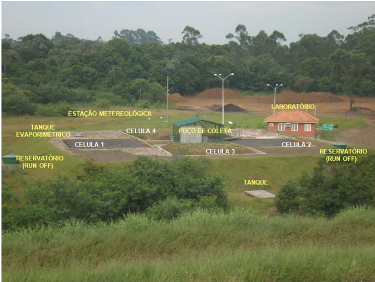
Figura 13. Vista geral da EEJPB.
