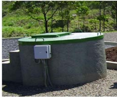
Vista externa do poço de coleta
