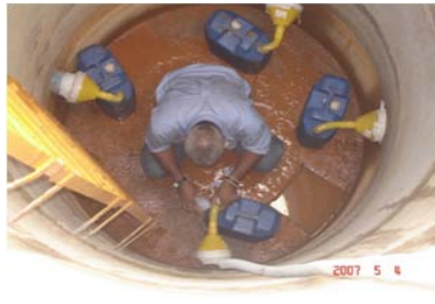
Vista interna do poço de coleta
