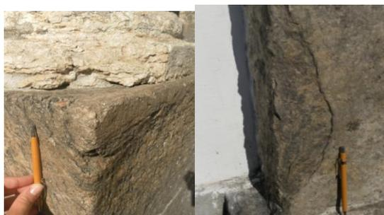
**Figura 1:** Exemplos de patologias de deterioração: a primeira apresenta uma perda de massa do calcário (superior) e intervenção inadequada (colagem de quina); a segunda apresenta uma combinação entre deslocamento, perda de massa e crosta negra.
