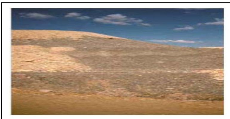
Figura 4. Cobertura seca em pilha de estéril em Leadville, CO. Foto de. Christine Costello, In: Acid Mine Drainage: Innovative Treatment Technologies. October 2003
