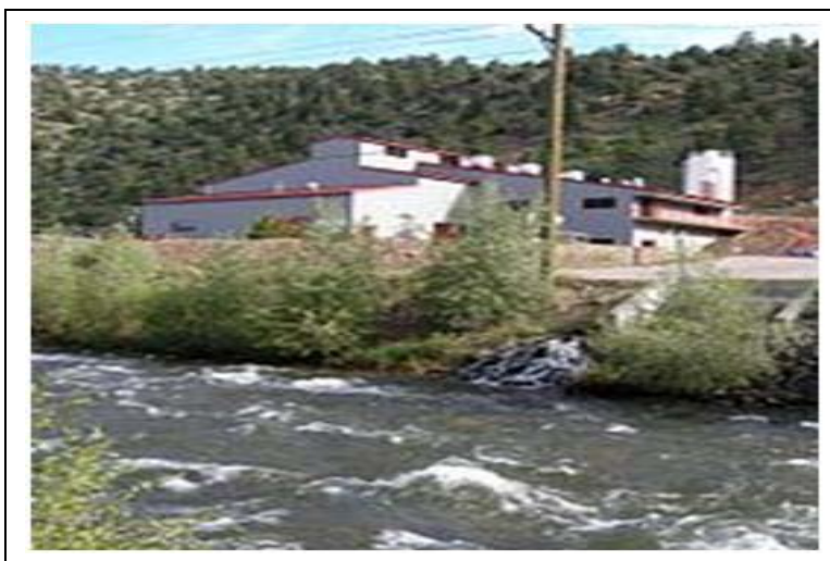
Figura 4. A estação de tratamento da Argo Tunnel remove metais e acidez antes da descarga do tunel fluir para Clear Creek. ( Acesso Internet Nov.- 2015).
