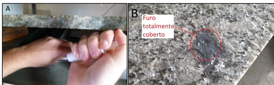
Figura 3: Aplicação de pasta térmica e detalhe do local de instalação.
