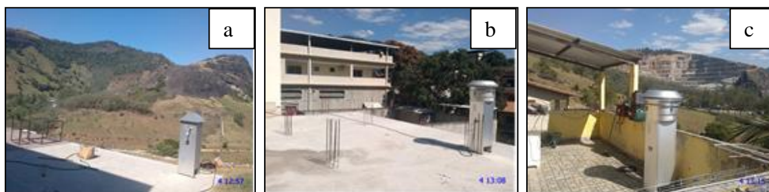
Figura 1: Amostradores de Grande Volume – AGV/“HiVol” instalados para medições de particulados no Bairro IBC, município de Cachoeiro do Itapemirim/ES.
