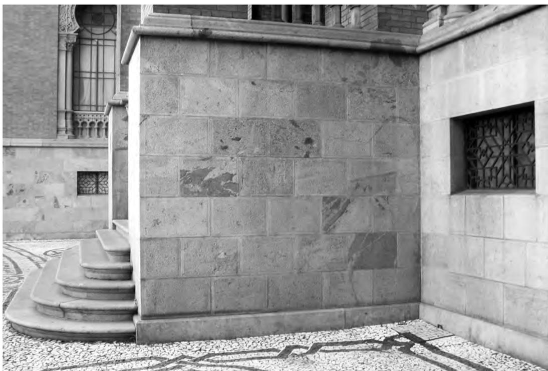
**Figura 6** - Base em alvenaria de pedra talhada, com acabamento apicoado. Castelo Mourisco, Rio de Janeiro (RJ). Foto: M.H.B.O. Frasca.
