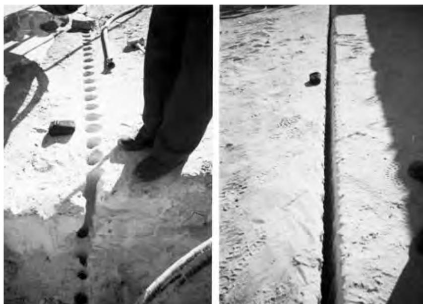
**Figura 66** - Detalhe de corte realizado com furos contínuos.
