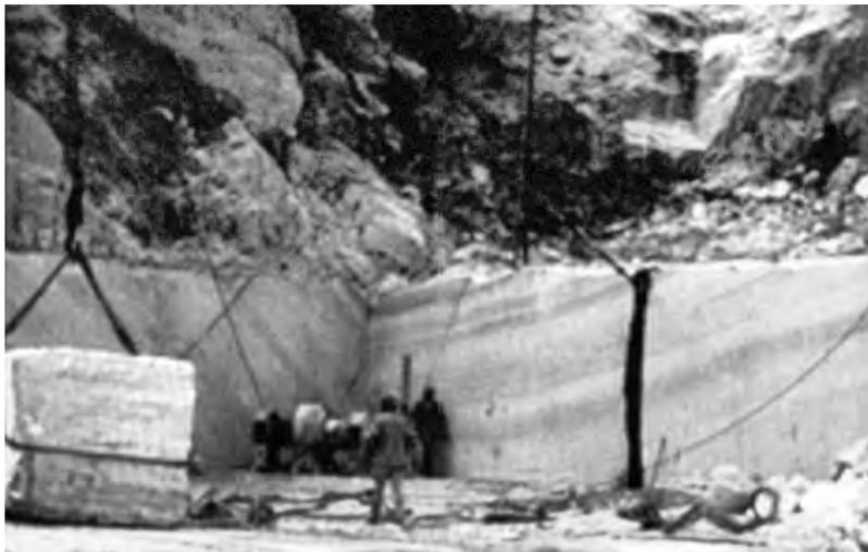
**Figura 98** - Guincho para içamento de blocos. Foto: CETEM/MCTI, 2006.
