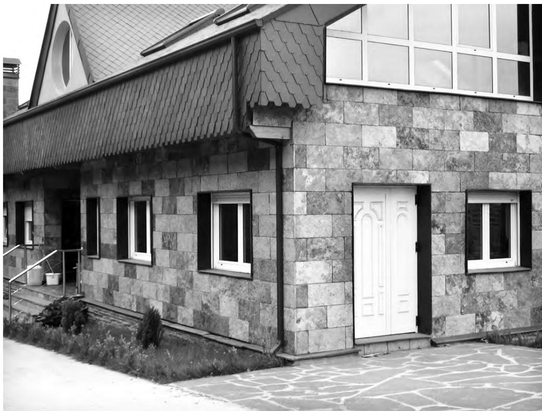
**Figura 4** - Residências europeias construídas com alvenaria de pedra (granito) e com telhados revestidos de ardósias. Foto: M.H.B.O. Frascá.
