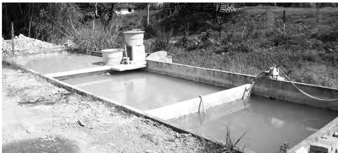
**Figura 21** - Unidade de decantação constituída de três tanques. Foto: CETEM/MCTI, 2002.
