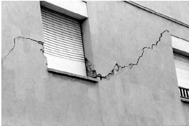
**Foto 1. Detalle de unas grietas en edificios del *Barri de l'Estació* (Sallent, Catalunya)**
