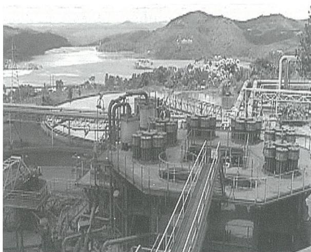
**Figura 5: Detalhes do circuito de flotação e espessamento das lamas e, ao fundo, vista parcial da barragem de rejeitos.**
