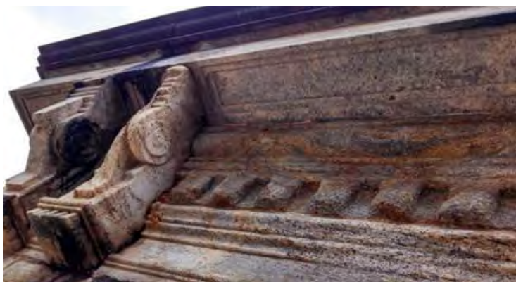
Figura 17. Detalhe da alteração, com granadas oxidadas e perda de material.
