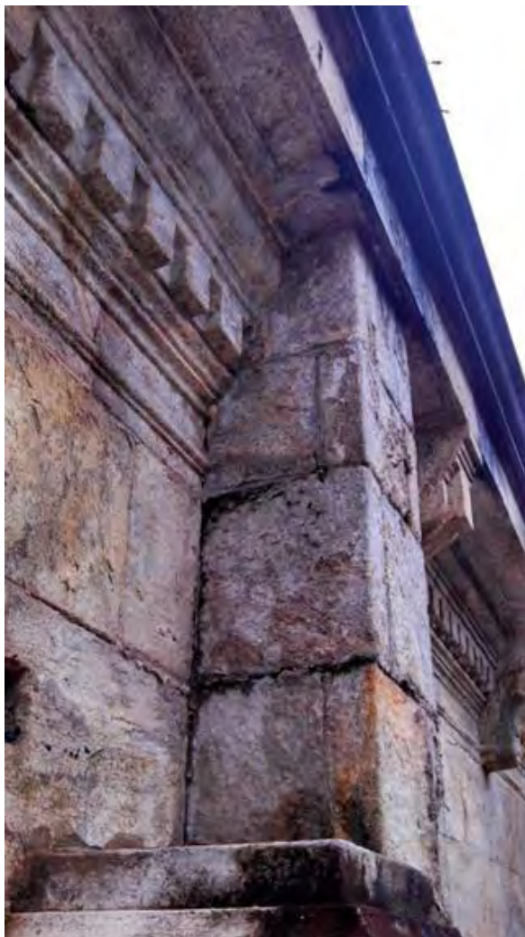
Figura 19. Rocha em pleno processo de escamação.
