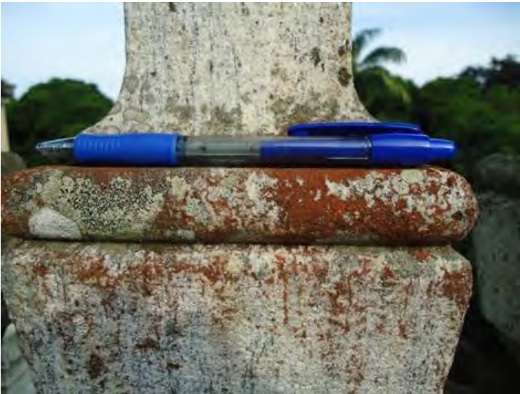
Figura 16. Balaústre com colonização biológica.
