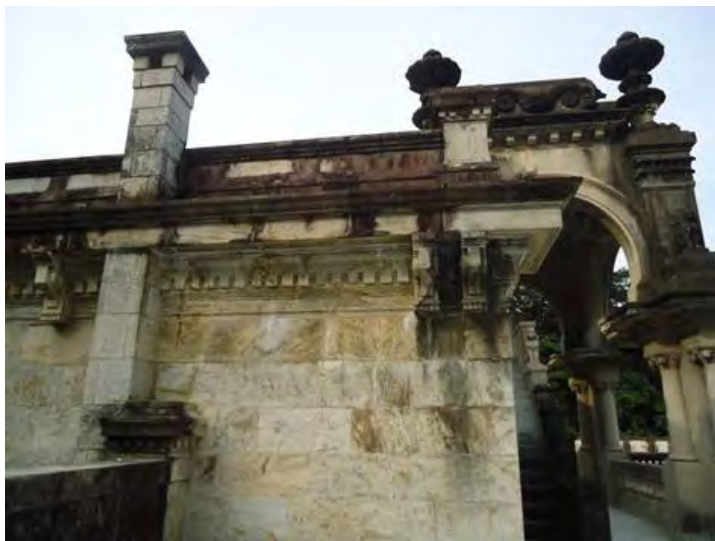
Figura 17. Detalhe da alteração, com granadas oxidadas e perda de material.
