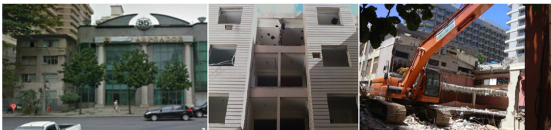
Figura 1: Fasesde pós-uso:prédios originais, fase da demolição seletiva e demolição destrutiva dos prédios
