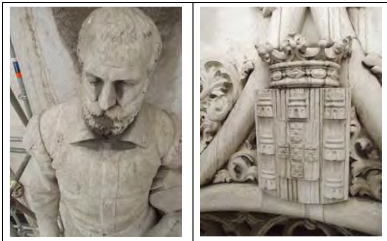
Figura 16. Alteração mineral (formação de gipso) na superfície da rocha.
