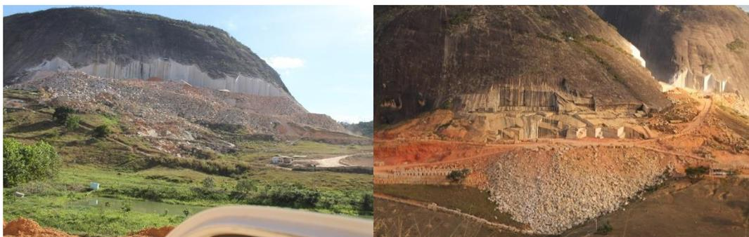
**Figura 1:** Frentes de lavra ativa (à esquerda) e inativa (à direita). Essas imagens ilustram os resíduos grossos encontrados à jusante da frente de lavra, que foram gerados pela atividade de extração.
