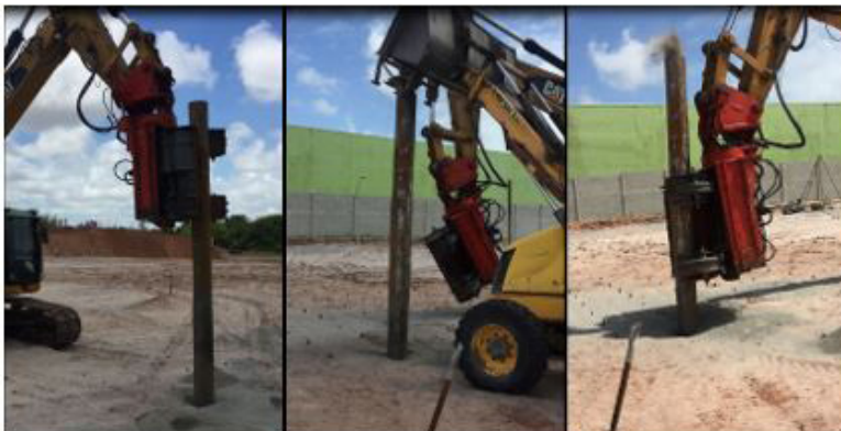
Figura 3- Processo construtivo terra-pobre: da esquerda para direita, cravação do tubo, enchimento com pó-de-pedra e retirada do tubo (FONTE: Acervo pessoal de Guilherme Ogliari).
