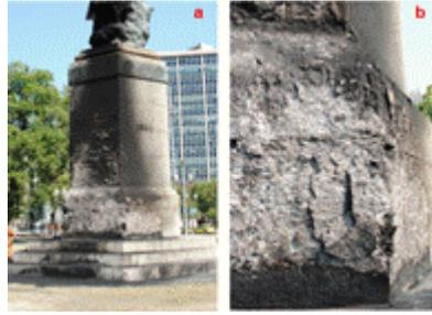
**Figura 2A:** Monumento pós-incêndio **2B** detalhe da esfoliação da rocha.
