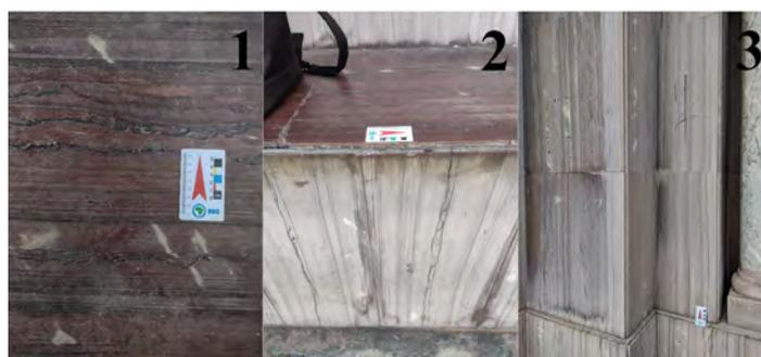
**Figura 2:** Mármore Vermelho Esperança com alteração de coloração no Santuário Basílica São Sebastião dos Frades Capuchinhos - **a)** Banco com coloração avermelhada; **b)** Comparação de tons do banco e da fachada; **c)** Fachada com revestimento esbranquiçado.
