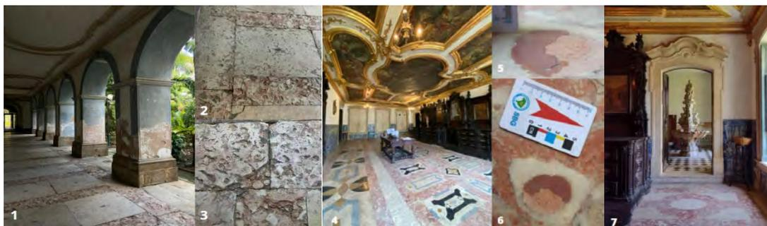
**Figura 1:** 1) Claustro. 2 e 3) Deterioração do piso do Claustro. 4) Sacristia. 5) Resina descolando. 6) Restauração com resina imitando o padrão fossilífero do Lioz Encarnadão. 7) Foto na Sacristia visando a Sala do Lavabo, fonte em foco.
