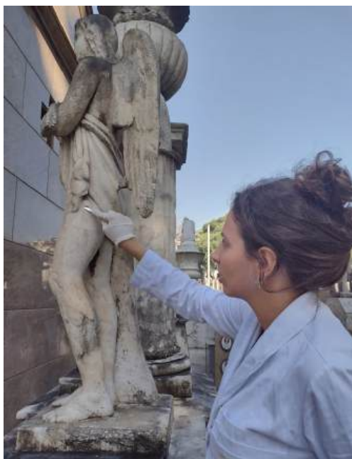
Figura 9. Levantamento de dados para realização do mapeamento de danos.
