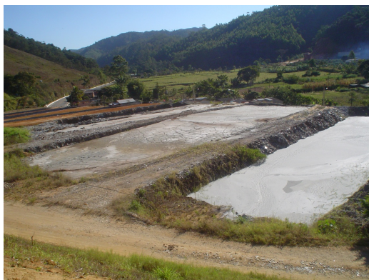
Figura 3- Tanque para deposição de lama abrasiva
