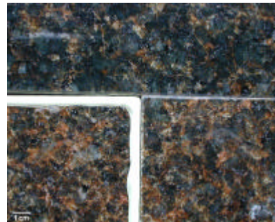
Figura 3 – Exposição à névoa salina. Aumento da oxidação preexistente (acima, corpo-de-prova de controle).
