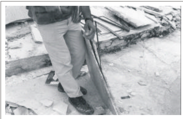
Fotografia 03: Planos preferenciais de partição (foliação metamórfica paralelizada a uma possível estrutura primária S_0 ), aproveitados para o deslocamento dos quartzitos.
