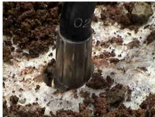
Foto 5 – Detalhe da introdução do cabo no furo a ser sondado
