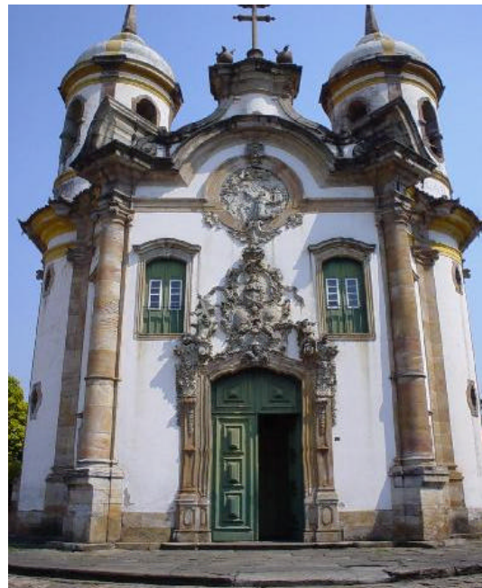
Figura 02: Exemplo de aplicação de esteatito nas peças que compõem o frontispício da igreja de São Francisco de Assis, em Ouro Preto Minas Gerais. No mesmo monumento observa-se a aplicação de quartzito, enquanto elemento de estruturação e de revestimento. Notar distribuição não harmoniosa das cores por parte do material quartzítico.
