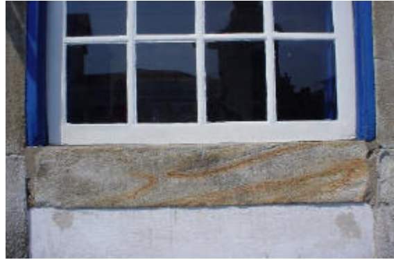
Figura 03: Construção histórica da região de Ouro Preto com quartzito mostrando variação de coloração, como resultado da atuação de processos de alteração de parte de seus constituintes mineralógicos.
