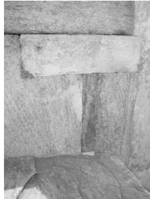
**Figura 04 - Construções históricas da região de Ouro Preto com utilização do quartzito, enquanto elemento de estruturação ou de revestimento, mostrando esfoliação e intensa variação de coloração, como resultado da atuação de distintos processos de alteração de parte de seus constituintes mineralógicos.**
