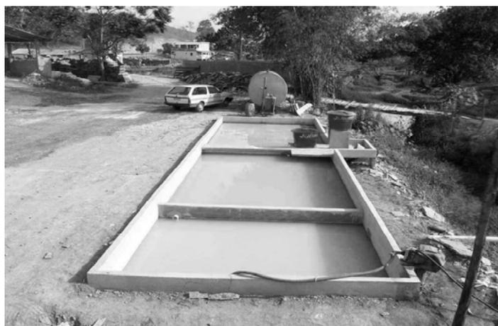
**Foto 6 - Estação de tratamento de efluentes da Serraria de propriedade do Sr. Carlos Rolla.**
