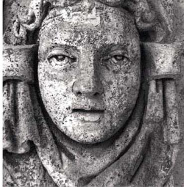
**Figura 1 -** Estátua de calcário travertino na fachada da Basílica de São Pedro (Vaticano) deteriorada pela ação de poluentes trazidos para a superfície da rocha pelo ar (na forma de gases ou aerossóis) ou pela água (chuva ácida).
