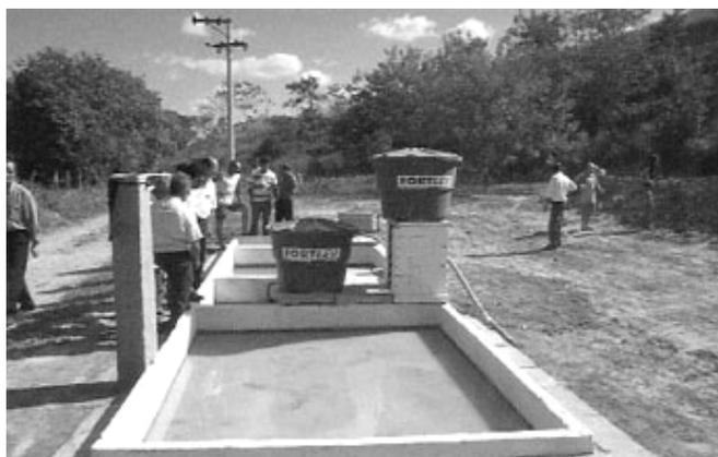
**Foto 5 - Estação de tratamento de efluentes da Serraria de propriedade do Sr. Antônio Camacho**
